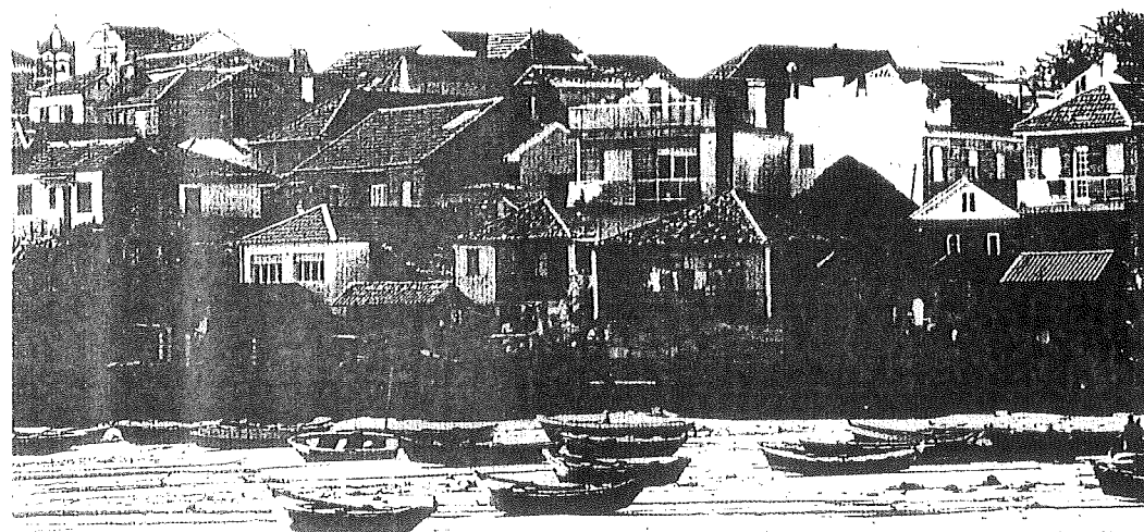
Foto 3. Alteracións volumétricas no nivel inferior de "A Rúa". 1990
